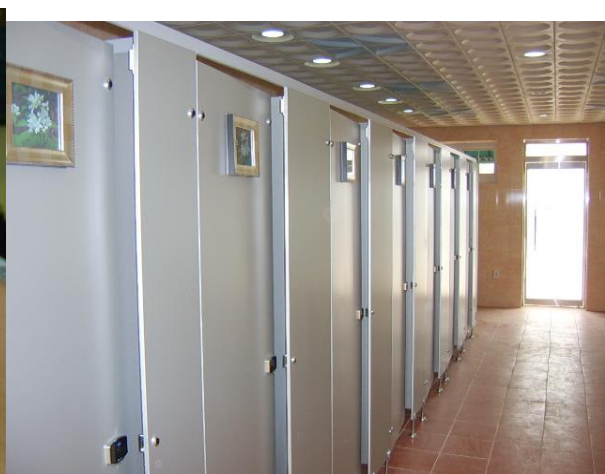
Toilet Door & Partition
